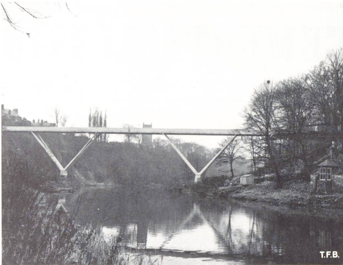
Abb. 1 Die fertiggestellte Brücke über den Wear in Durham.
