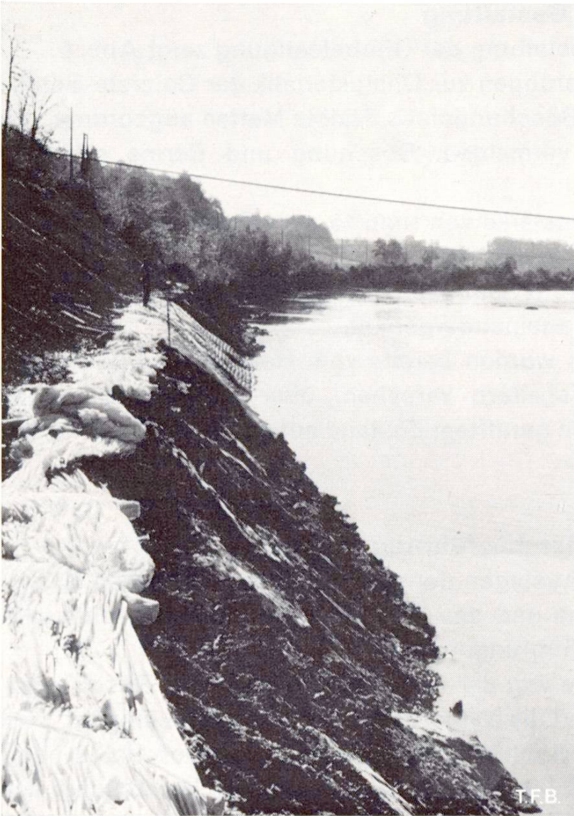
Abb. 7 Geraffte Nylon-Plane auf der Berme. Man erkennt gut die sehr steile Böschung (Neigung > 1:1 ) sowie die grossen Unregelmässigkeiten an der Böschungsoberfläche.
