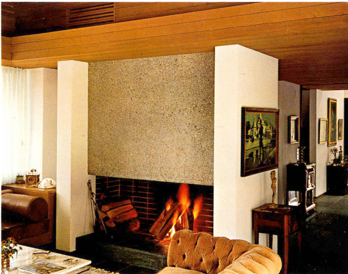
Cheminée mit Sichtbetonfront im Wohnraum.
