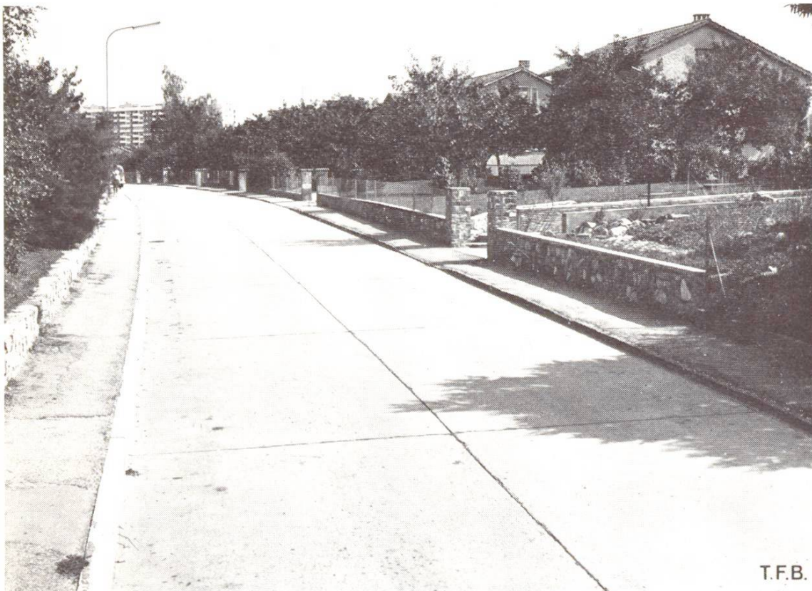
Abb. 3 Erschliessungsstrasse für «Coin de terre» in Lignon bei Genf, erstellt 1953. Diese Strasse hat die Erwartungen der Langlebigkeit mehr als erfüllt.
