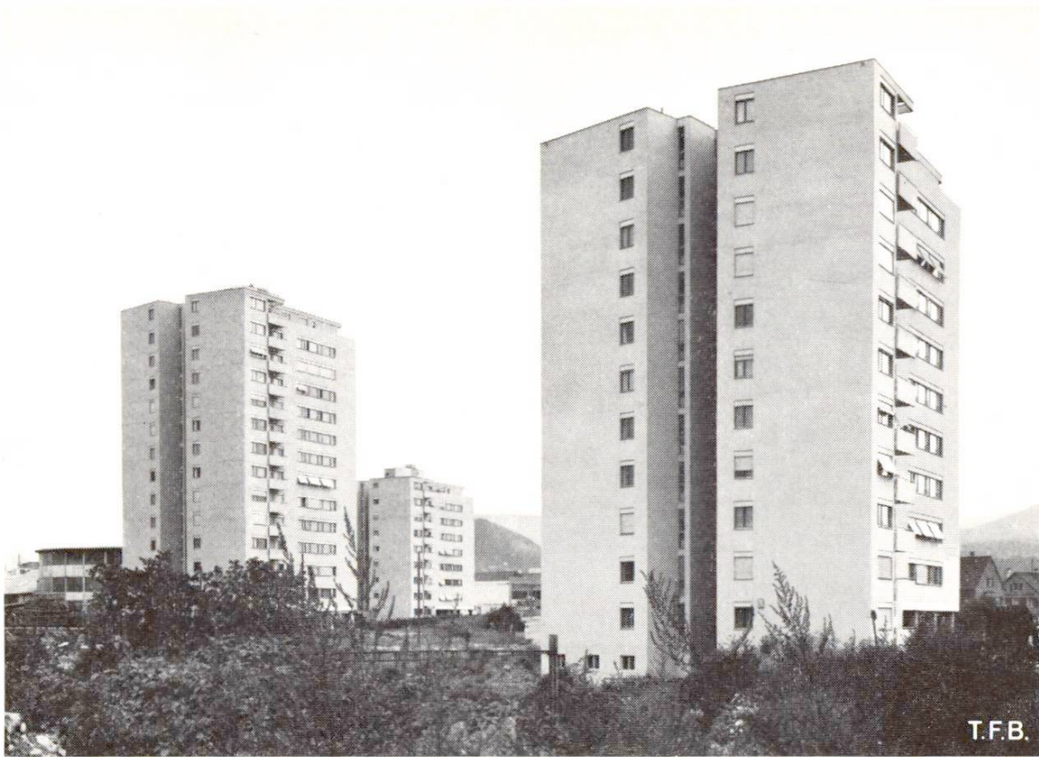
Abb. 2 SBB-Hochhäuser «Stegacker», Muttenz
