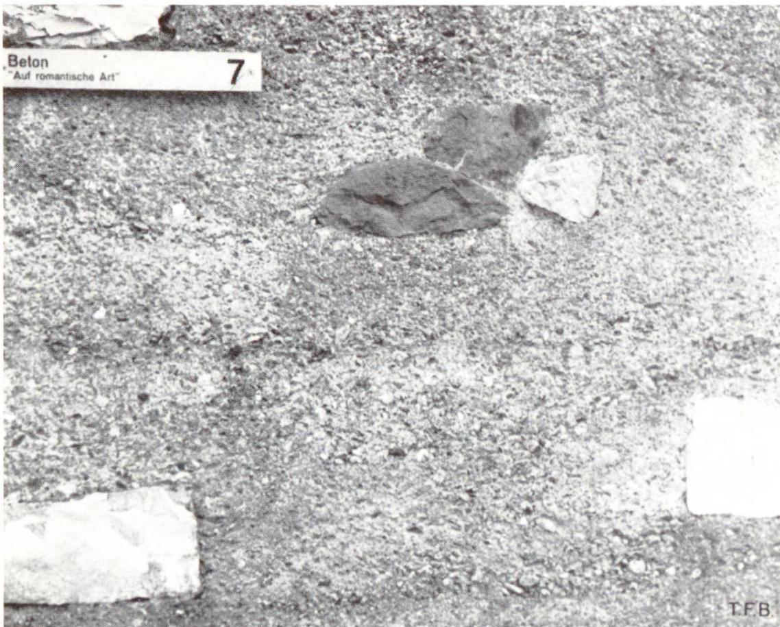
Abb. 7 und 8 Stützmauer mit Anzug wie Abb. 1 und 2. Aufnahmen 1962 bzw. 1972. Rohgestockter Beton mit eingeschlossenen grösseren Natursteinen. Der farbliche Gesamtaspekt ist bei diesem Mauerstück unruhiger geworden. Die gebrochenen Flächen der Natursteine haben ihre Farbe teilweise stark geändert. Die entstandenen wolkenförmigen Grautonkontraste sind vermutlich die Folgen von lokalen Unterschieden des Wasserzementwertes in eingebrachtem Frischbeton, indem dadurch unterschiedlich durchlässiger Zementstein entstand.
