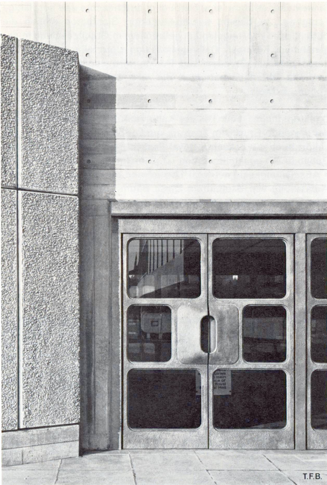
Abb. 8 Einzelheiten der Fassade bei den Eingängen: Aluminiumtüren, körnige Platten und formenreicher, regelmässiger Sichtbeton. Man erkennt hier die Ausbildung der Bindelöcher: Sie sind kreisrund mit dichtem, ebenem Mörtelverschluss, 10 mm zurückversetzt.
