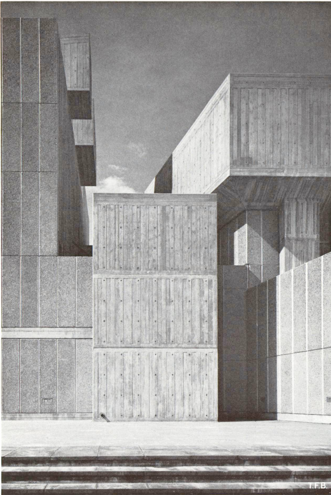
Abb. 5 Diese Aufnahme zeigt die beiden Hauptmotive der Betonfassaden, die «Holzkisten-Schalttafel» und die hochgestellte Platte mit freigelegtem Zuschlagskorn.
