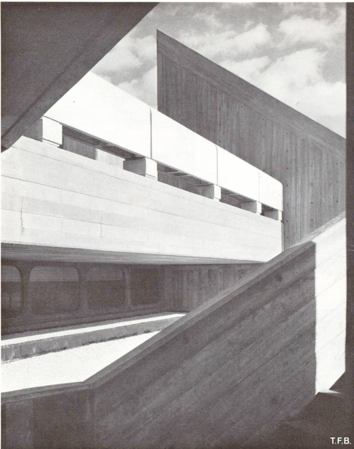
Abb. 3 Sichtbeton aus sorgfältig erstellten Schalungen mit gehobelten und rauhen Brettern. Formgebung der abfallenden Mauerkrone unmittelbar nach dem Verdichten des Betons.
