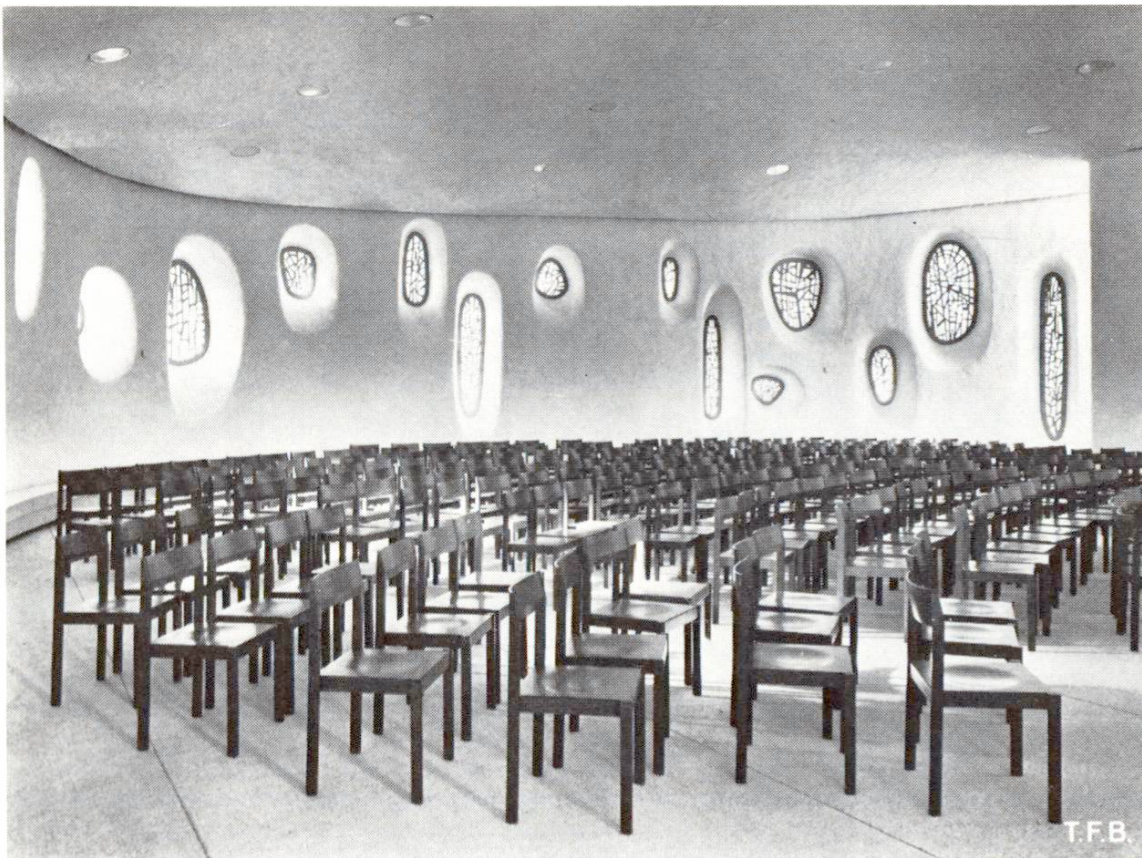
Abb. 5 Innenseite der Kirche St-Jean in La Chaux-de-Fonds. Die freie Formgebung durch Spritzbeton kommt hier besonders bei den Fensterdurchbrüchen zur Geltung. Grundlage der Fenster waren zwei ineinanderpassende ausgesteifte Rahmen aus Winkeleisen, von denen der äussere während des Spritzvorganges einbetoniert wurde und der innere in die Werkstatt des Kunstglasers gebracht worden ist. Auch die Decke wurde im Spritzbetonverfahren in mehreren Schichten aufgebaut, wobei vom zentralen Turm tragende Streifen radial gegen aussen angeordnet worden sind. Dazwischen wurde wiederum Füllmaterial aus Schaumstoff eingelegt. Die Deckenuntersicht wurde auf eine zusätzliche Isolationsschicht aufgespritzt.
