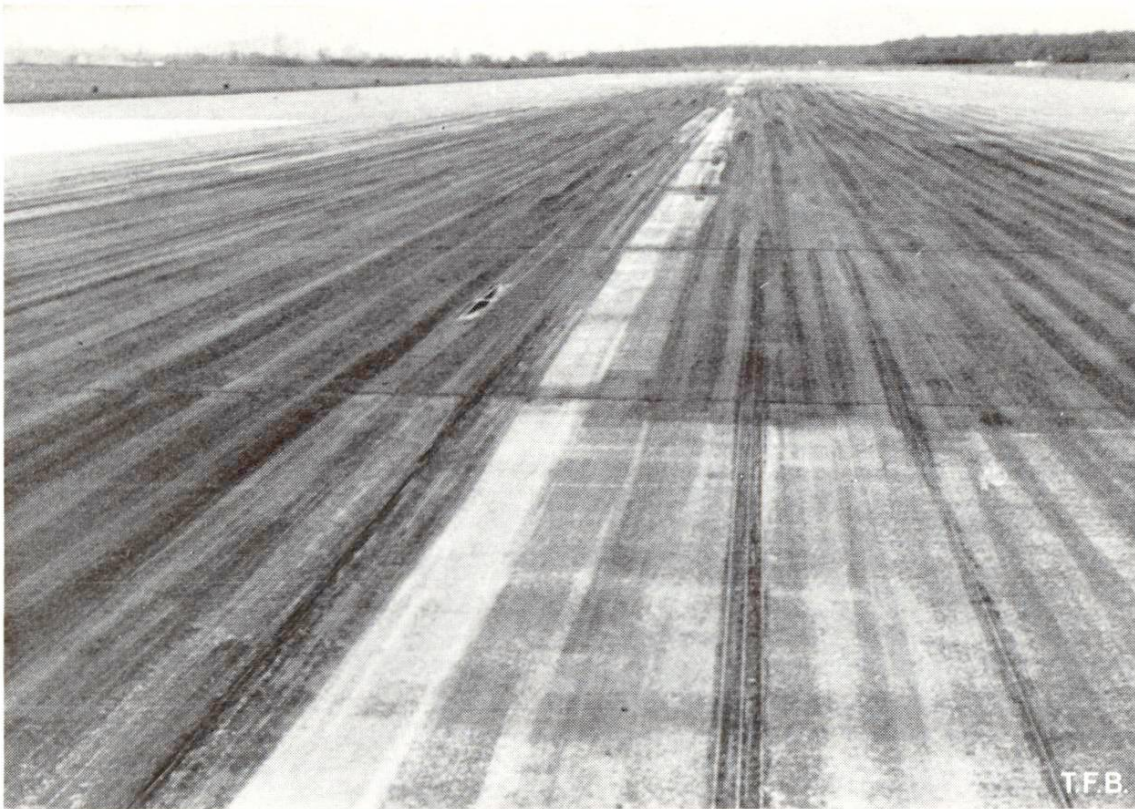
Abb. 3 Ein Teil der mit Gummiregenerat überzogenen Landepiste. Die Partie im Vordergrund rechts wurde der Behandlung unterzogen, zeigt aber bereits neue Radschuren eines inzwischen gelandeten Flugzeuges.
