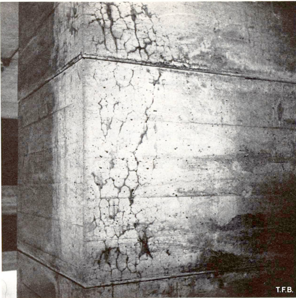
Abb. 5 Fröhschwindrisse an vorspringendem Bauteil infolge rascher Austrocknung kurz nach dem Ausschalen. Rissabstand 50 bis 70 mm.
