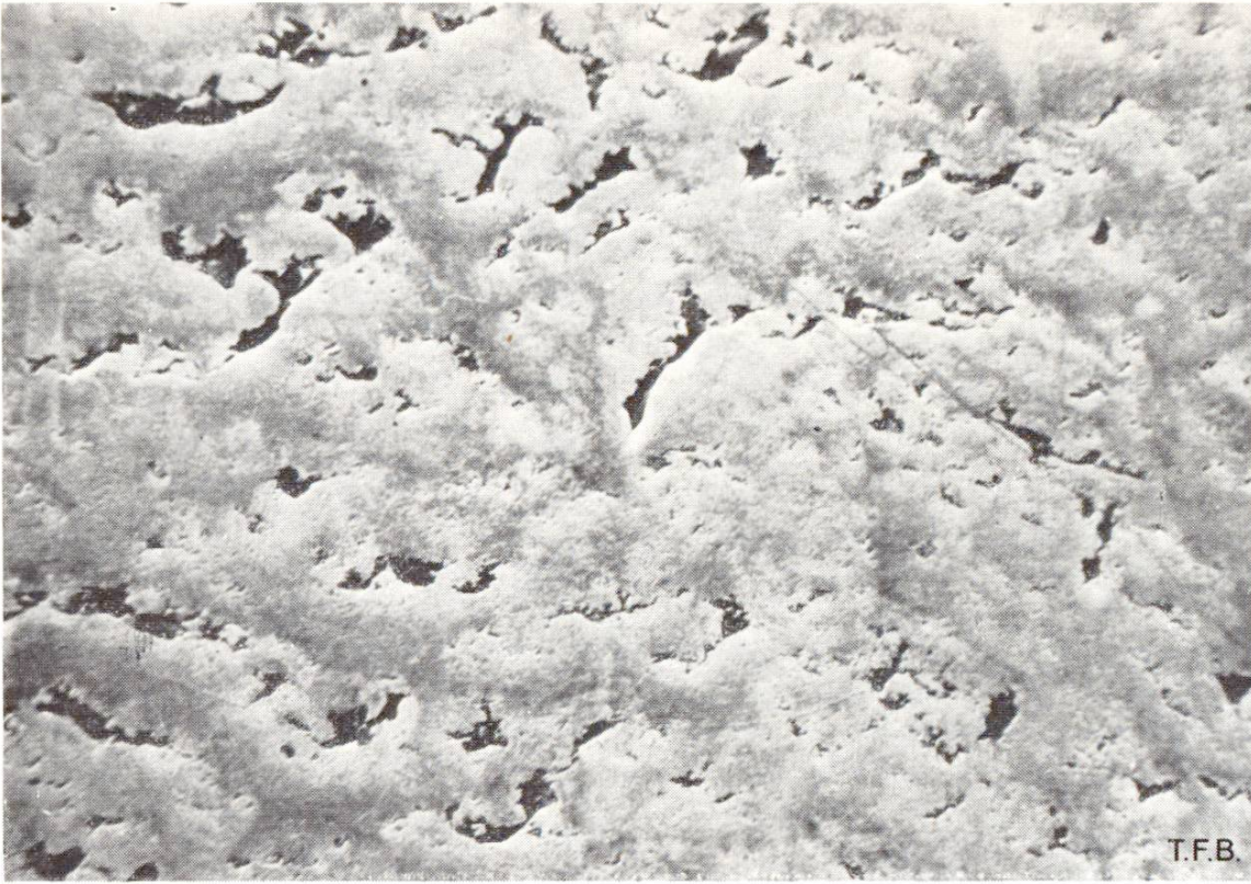
Abb. 4 Kiesnest, das während der Vibration teilweise ausgefüllt worden ist. Man erkennt die typisch schlierenförmigen Hell-Dunkel-Verfärbungen des Mörtels infolge Wasser-Zementmischung während des Fließvorganges (hell: mehr Wasser, dunkel: mehr Zement).
