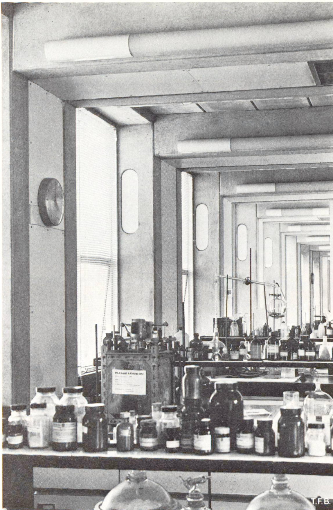
Abb. 5 Fensterfront eines Studentenlabors. Die Doppelsäulen enthalten die Versorgungsleitungen. Die Zwischenräume sind mit leicht entfernbaren Pressholzplatten abgedeckt. Der Abstand der Stützen beträgt 3 m.
