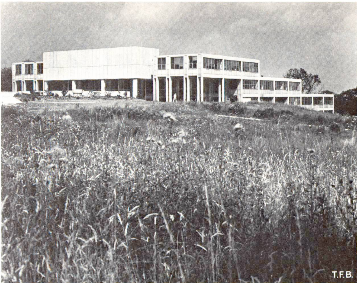
Abb. 2 Seitliche Ansicht. Das Gebäude ist nach rückwärts dem Gelände entlang abgestuft. Im obersten Geschoss sind Bibliothek (im geschlossenen Kubus), Verwaltung und Forschungslaboratorien untergebracht, während die unteren Teile Studentenlabors, Seminarräume und Werkstätten enthalten.
