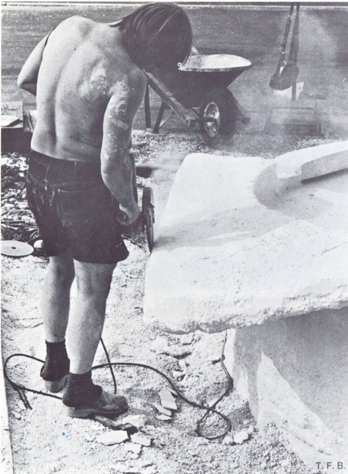
Abb. 5 Schlussbearbeitung mit der Schleifscheibe. Sichtbarlassung der Spritzstruktur im Wechsel zu glatt geschliffenen Kanten und Flächen.
