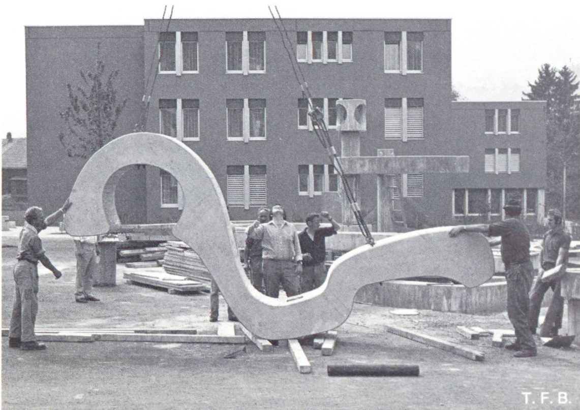
Abb. 5 Aufziehen des figürlichen Säulenaufsatzes zur Montage.
