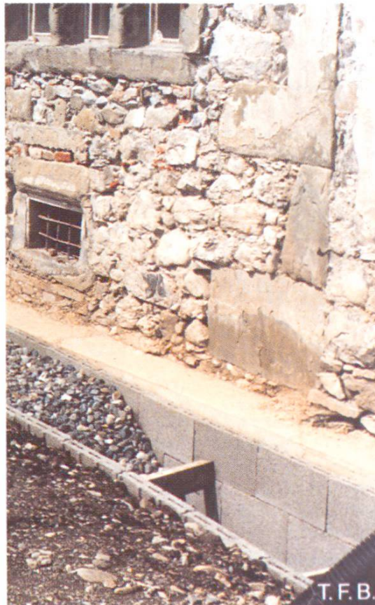
Abb. 21 Dieselbe Mauer nach Sicherung mit Fließbeton (HK als Bindemittel). Sickerpackung gemäss Abb. 19.
