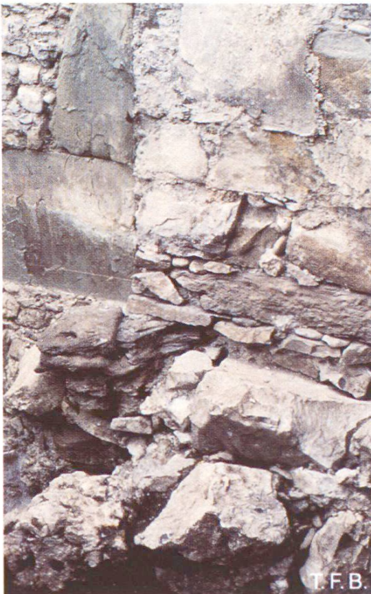
Abb. 20 Freigelegte Aussenseite eines Kellermauerwerks. Dieses musste gesichert werden.
