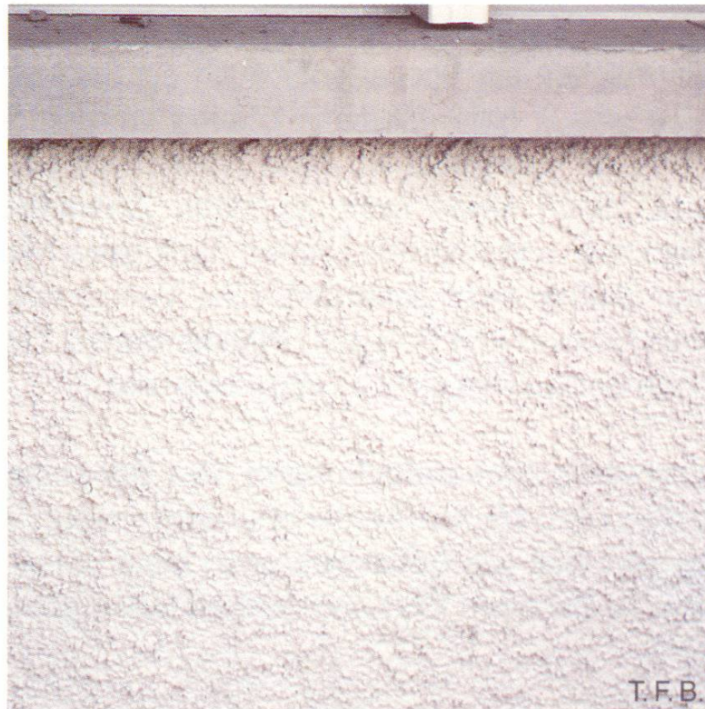
Abb. 14 Kellenwurf als Deckputz (Lindenplatz Pfungen).
