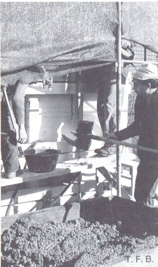
Abb. 8 Transportbeton aus der Mulde in den Kubel zur Schalung.
