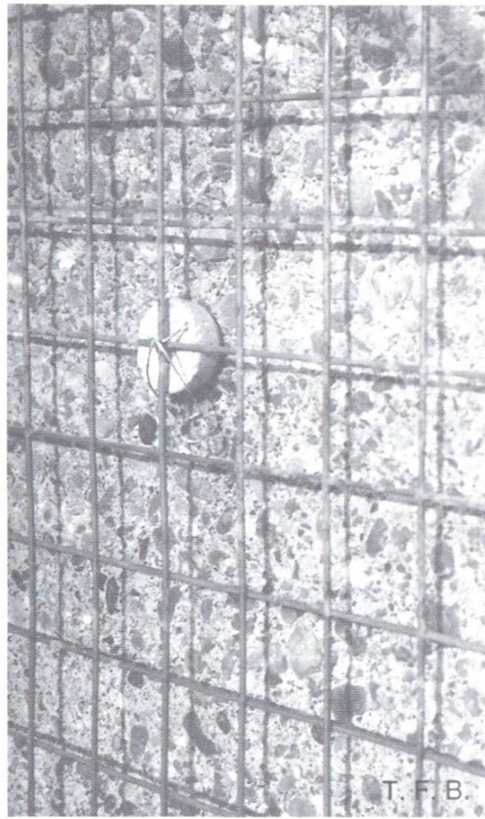
Abb. 7 Netzarmierung des Vorbetons, am bestehenden Beton gesichert.
