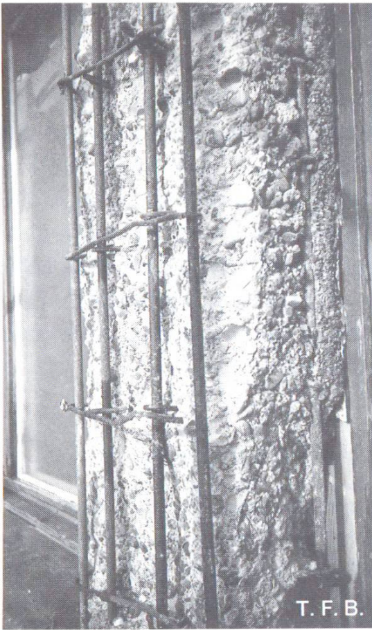
Abb. 6 Pfeiler, zum Einschalen vorbereitet.
