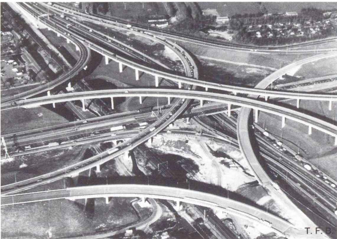
Abb. 6 Autobahnkreuz Rottepolderplein bei Den Haag (NL). Brückenbrüstungen mit MHK ausgeführt.
