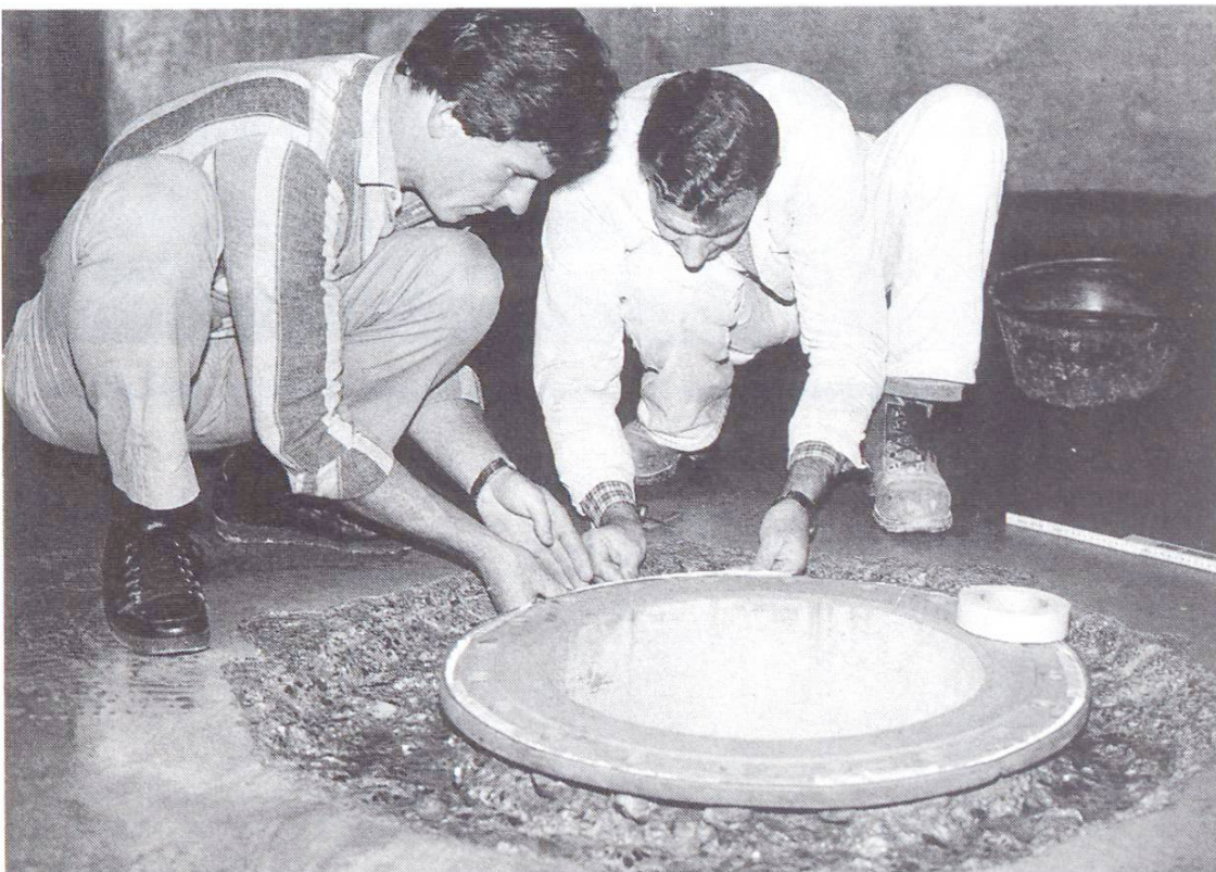
Abb. 6 Sanierung eines Flansches (vgl. Abb. 4) mittels Zementpassivierung.
