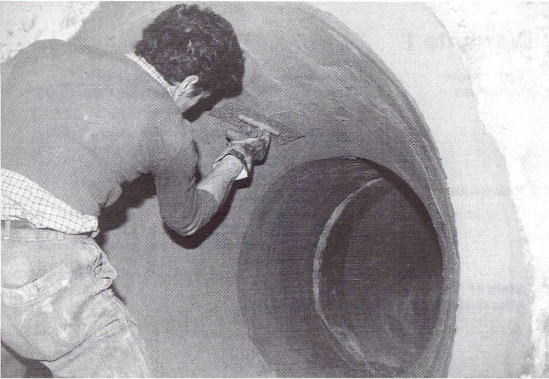
Abb. 7 Aufbringen einer Zementmörtelauskleidung.
