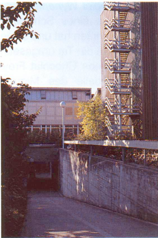
Farbliche Trennung von Fassaden und Tiefbauten (Schokoladefabrik) 3
