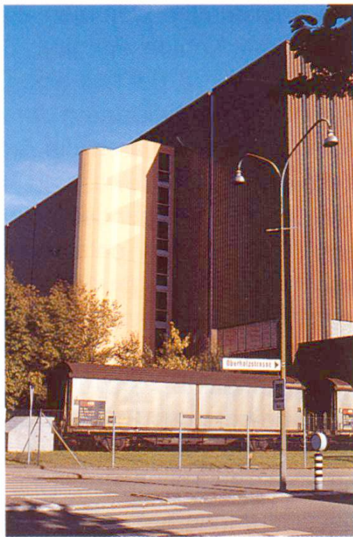
Betonschacht vor Metallfassade; intensivere Farben (Schokoladefabrik) 4
