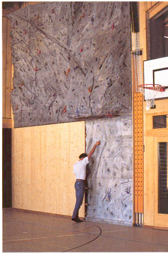
Möglichkeit zum Abdecken der unteren Partie (3 m) für Ballspiele oder Turnunterricht (Mehr- zweckhalle Schönried). 8
