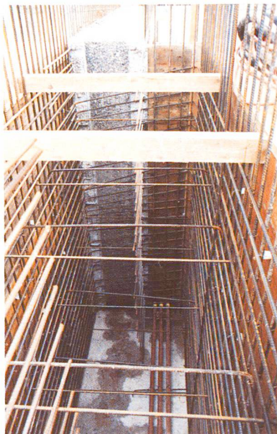
Abb. 5 Wandetappe, zum Betonieren vorbereitet. Gereinigt und angefeuchtet.
