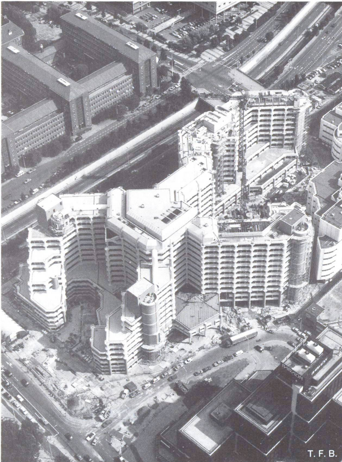
Abb. 2 Luftaufnahme des Gebäudes zwischen Prins Claus Laan (oben) und Prins Ireen Laan (unten)
