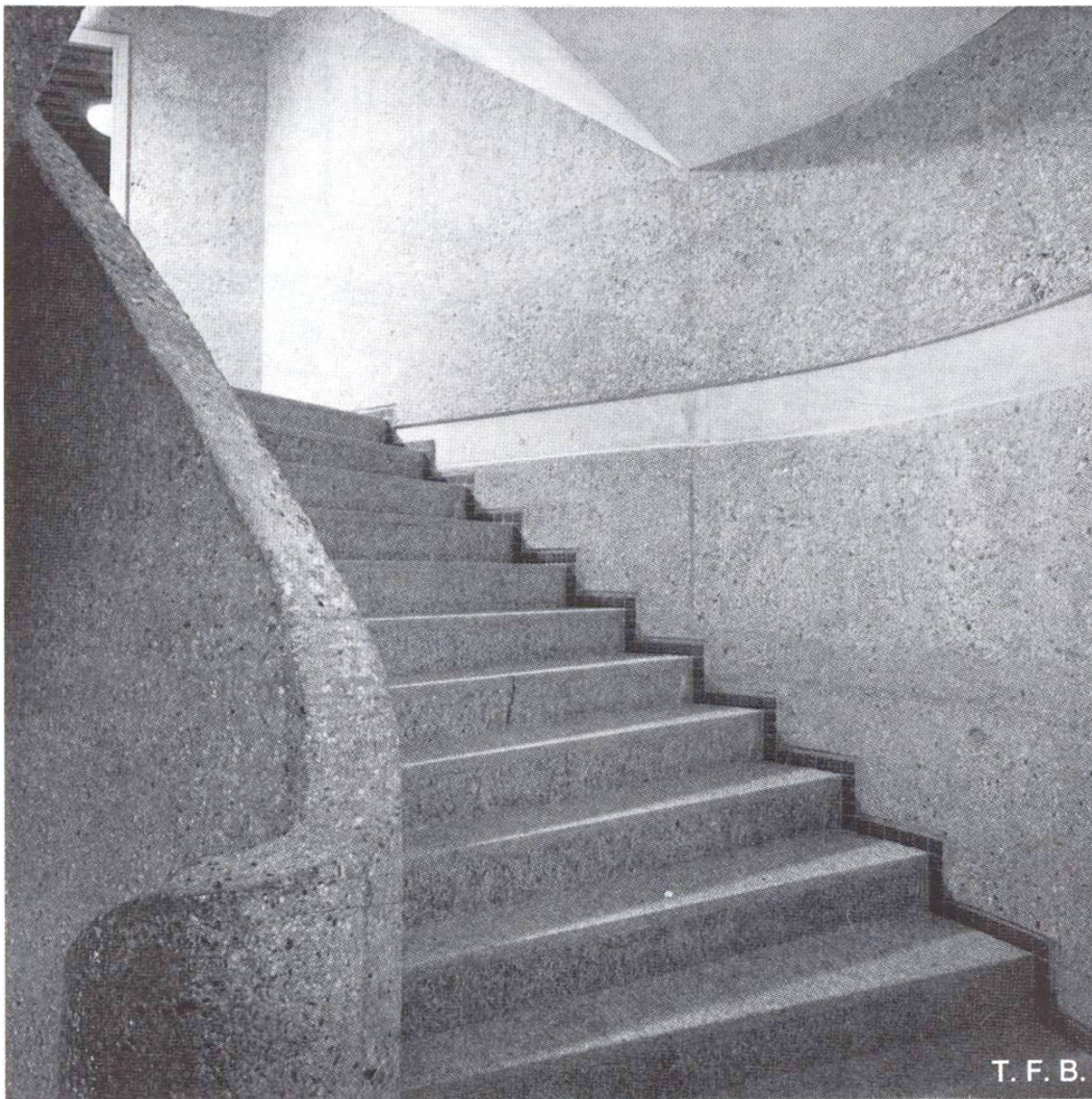
Abb. 7 Sichtbeton im Treppenhaus
