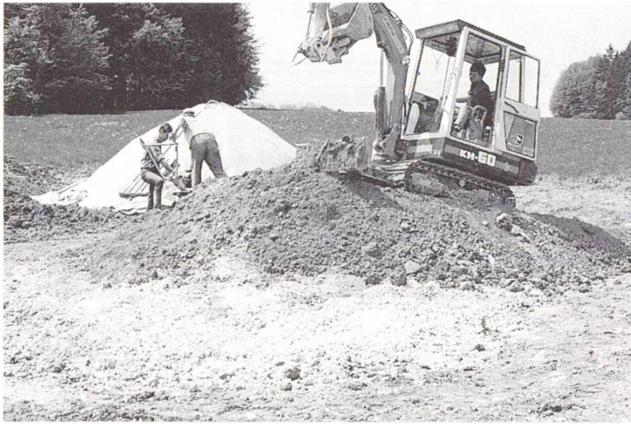
Abb. 11 Mischen mit Kleinbagger. Depot, mit Plastikfolie abgedeckt
