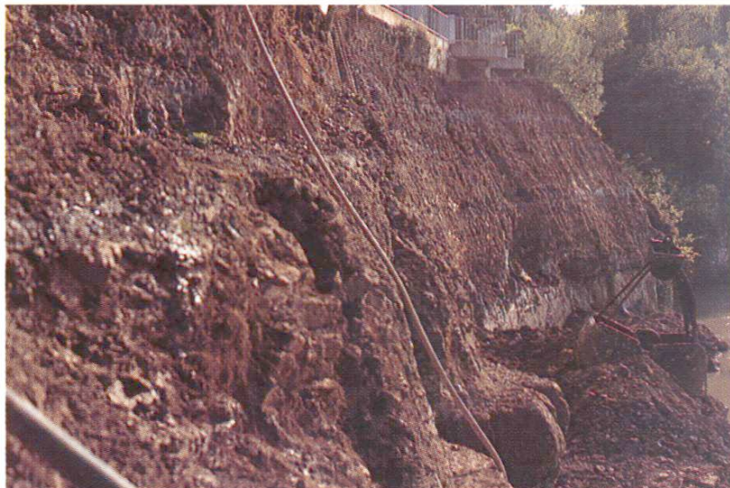
Abb. 9 Abtrag (wechselnde Hangneigung!)
