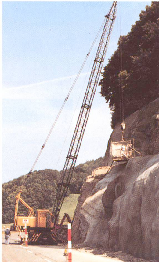
Abb. 14 Spritzbetonarbeiten ab Hängebühne
