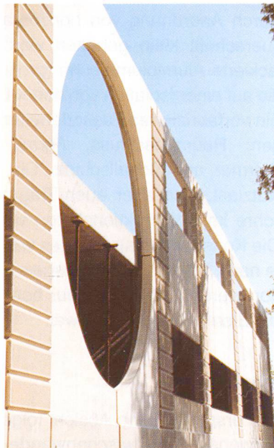
Abb. 8 Fassadendetail (West, Seite Park)
