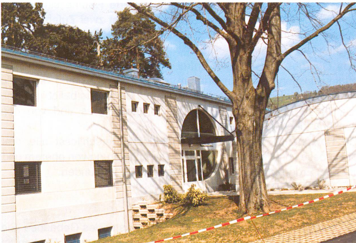
Abb. 1 Kundeneingang (Ost, Seite Autobahn)
