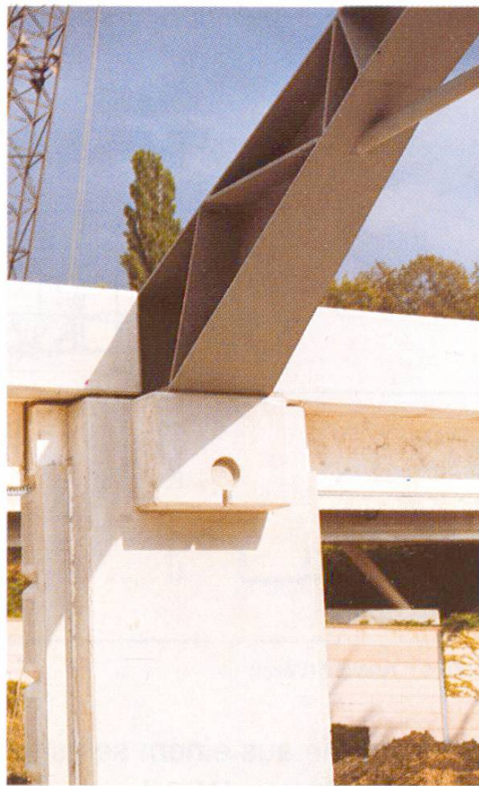
Abb. 7 Auflager für Stahlträger der Dachkonstruktion
