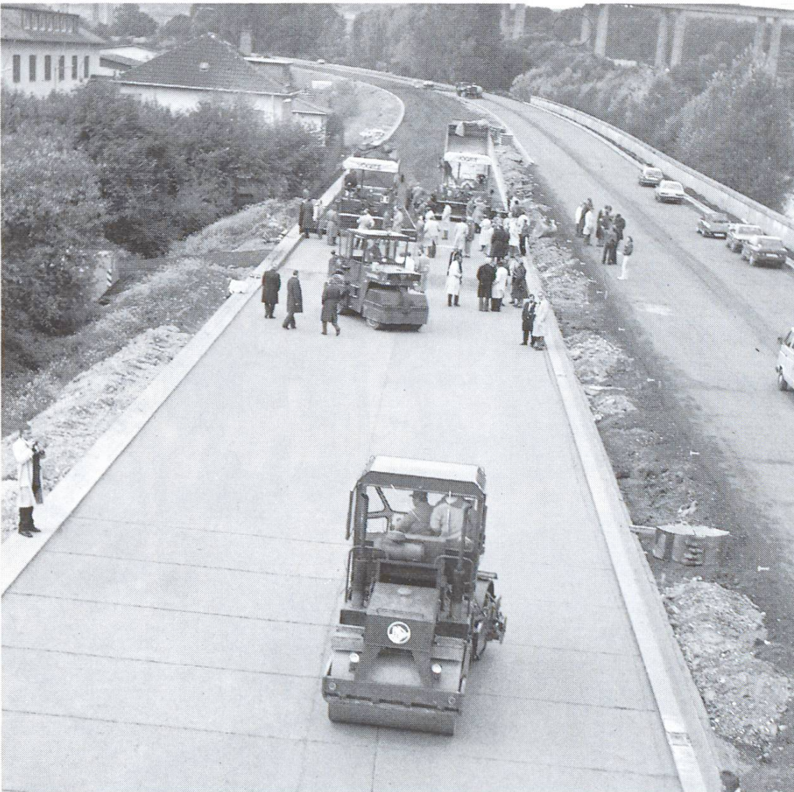
Zweispuriger Einbau von Walzbeton: Mit Kippnern antransportierte Walzbetonmischung wird an die Strassenfertiger übergeben, von diesen eingebaut und schliesslich mit Vibrationswalzen verdichtet (von hinten).
