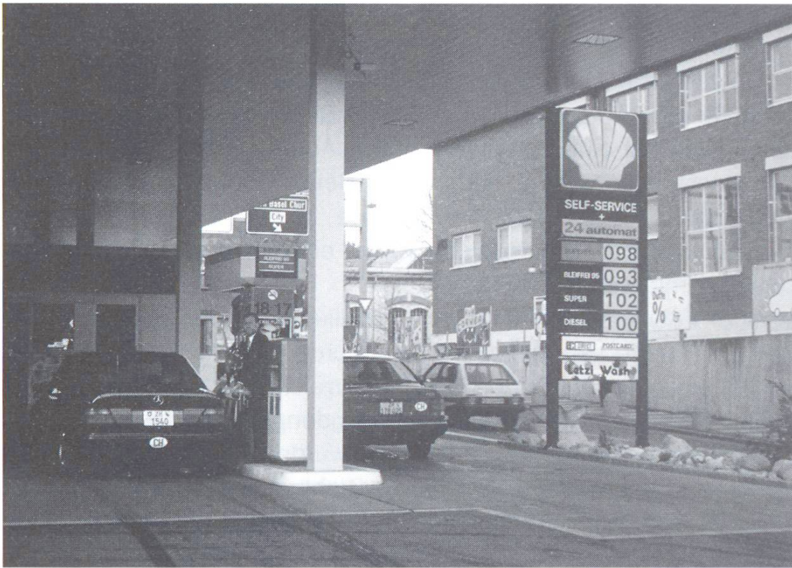
Bodenplatten aus Beton haben sich im Tankstellenbereich bewährt.
