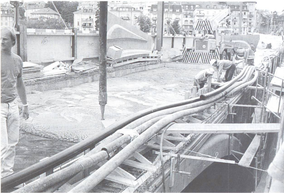
Verfüllen von Hohlräumen unter der zukünftigen Fahrbahnplatte auf einer Brücke in Lausanne.
