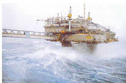
Hochleistungsbetone, die den Zusatzstoff Silicastaub enthalten, verleihen Bohrplattformen in der Nordsee Standfestigkeit und Dauerhaftigkeit.
