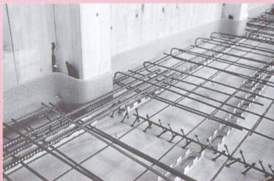
Auflagerdetail vor dem Betonieren.
