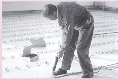
Setzen von zweireihig, paarweise angeordneten Verbundelementen mit einem Setzgerät.
