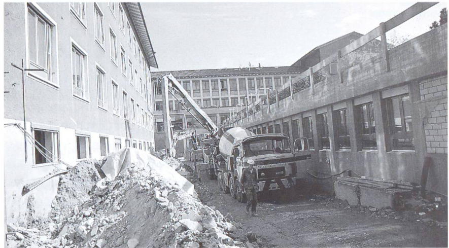
Foto: Werner Hauser, Betonpumpen AG, Zürcher Unterland, Dällikon
