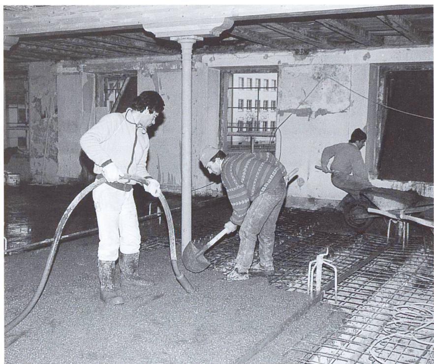
Altbausanierung mittels Holz-Beton-Verbundsystem (Leichtbeton LB 20/10, Rohdichte 1,5 kg/m 3 ).
