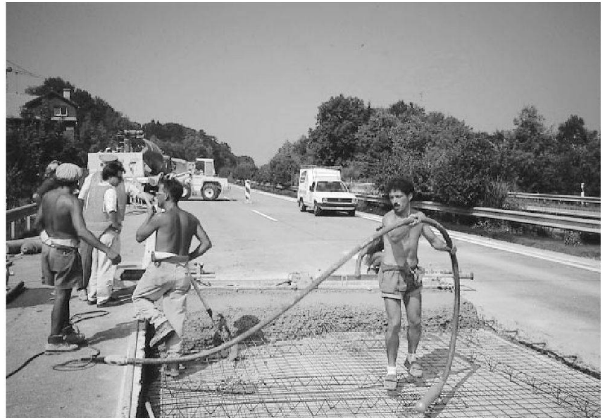
Teilersatz einer Betonplatte (A1).
