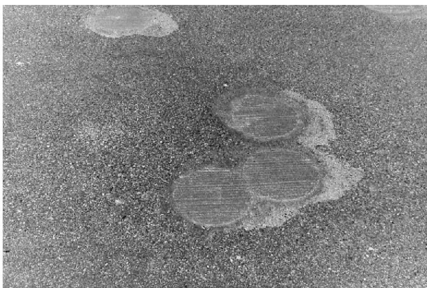
Reparierte Oberflächenschäden (Bohrungen mit Durchmesser 300 mm) auf der A8.
