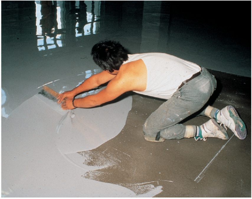
Auftragen eines rissüberbrückenden Fließbelags mittels einer Zahntraufel.
