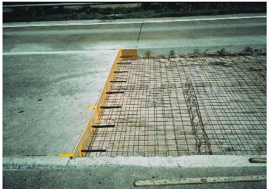
Plattenersatz: zum Betonieren vorbereitet.
