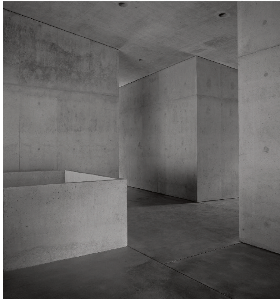
Korridor im Obergeschoss.
