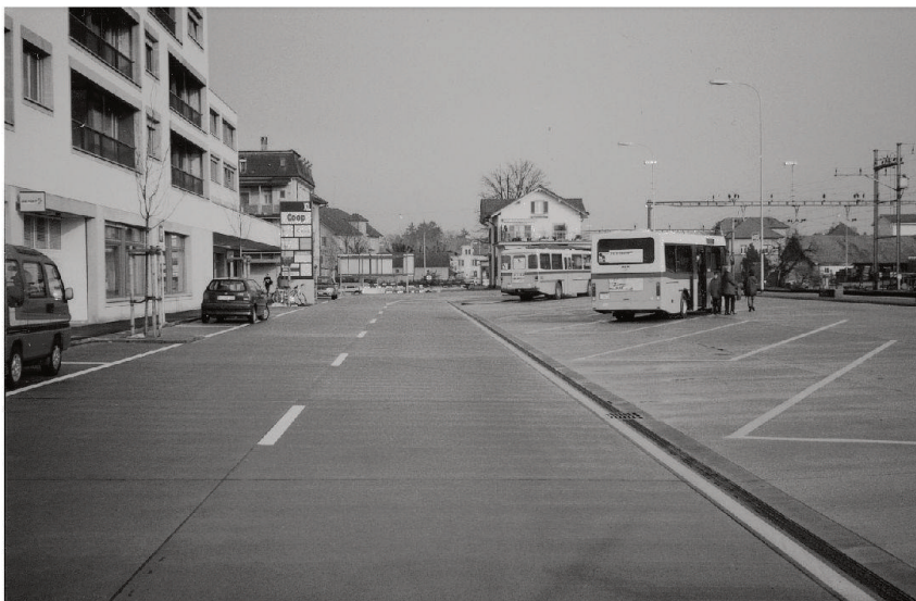
Laufenburg, Bahnhofplatz und Zufahrtstrasse in Beton.
