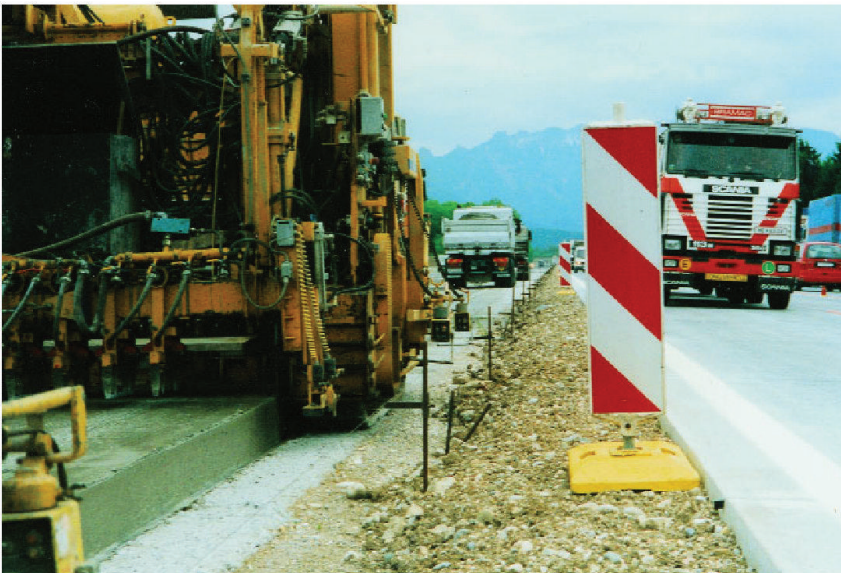
Abb. 3 Moderne Betondecken werden mit Gleitschalungsfertigern eingebaut.
