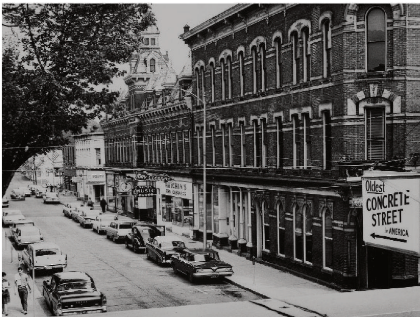
Abb. 1 In Bellefontaine, Ohio (USA), wurde 1894 die erste moderne Betonstrasse gebaut. Sie ist noch heute unter Verkehr!
