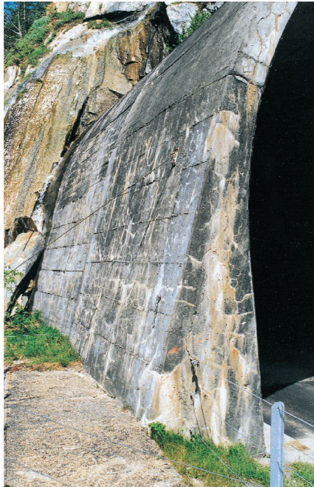
Abb. 5 Überlagerung von statischen, korrosions- und AAR-bedingten Rissen mit Kalkablagerungen. Foto: Fritz Hunkeler, TFB
