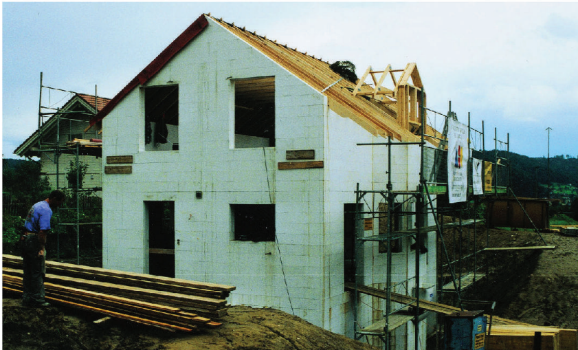
Rohbau des Musterhauses in Brittnau 15 Tage nach Baubeginn. Foto: Fritz Hunkeler, TFB
