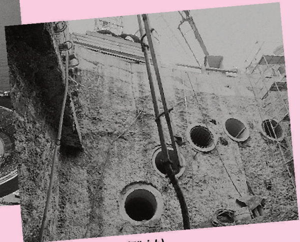
Rohrschirm aus SCC (Zürich)
