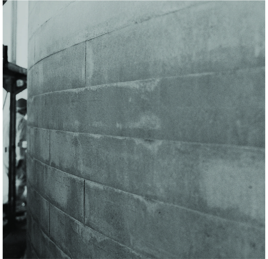
Die Spritzbetonoberfläche der gebogenen Wandfläche des Schiffs der Kirche St. Karl in Luzern wurde mit einer Schalbrettstruktur versehen.
