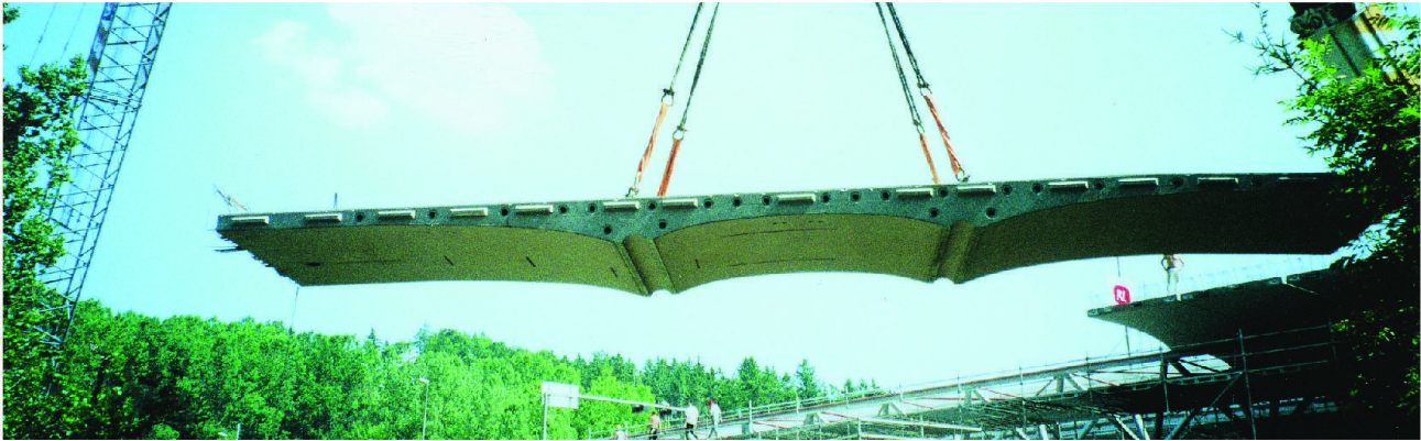
Abb. 2 Mit dem grössten Raupenkran der Schweiz wird eine der 61 vorgefertigten Platten der neuen Talbrücke der A 1 in Dättwil versetzt. Diese sind 15,90 m lang, 3,20 m breit und an den dünnsten Stellen 0,25 m dick.
