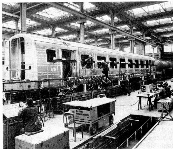
Construction d'un wagon CFF à Neuhausen (SIG).
