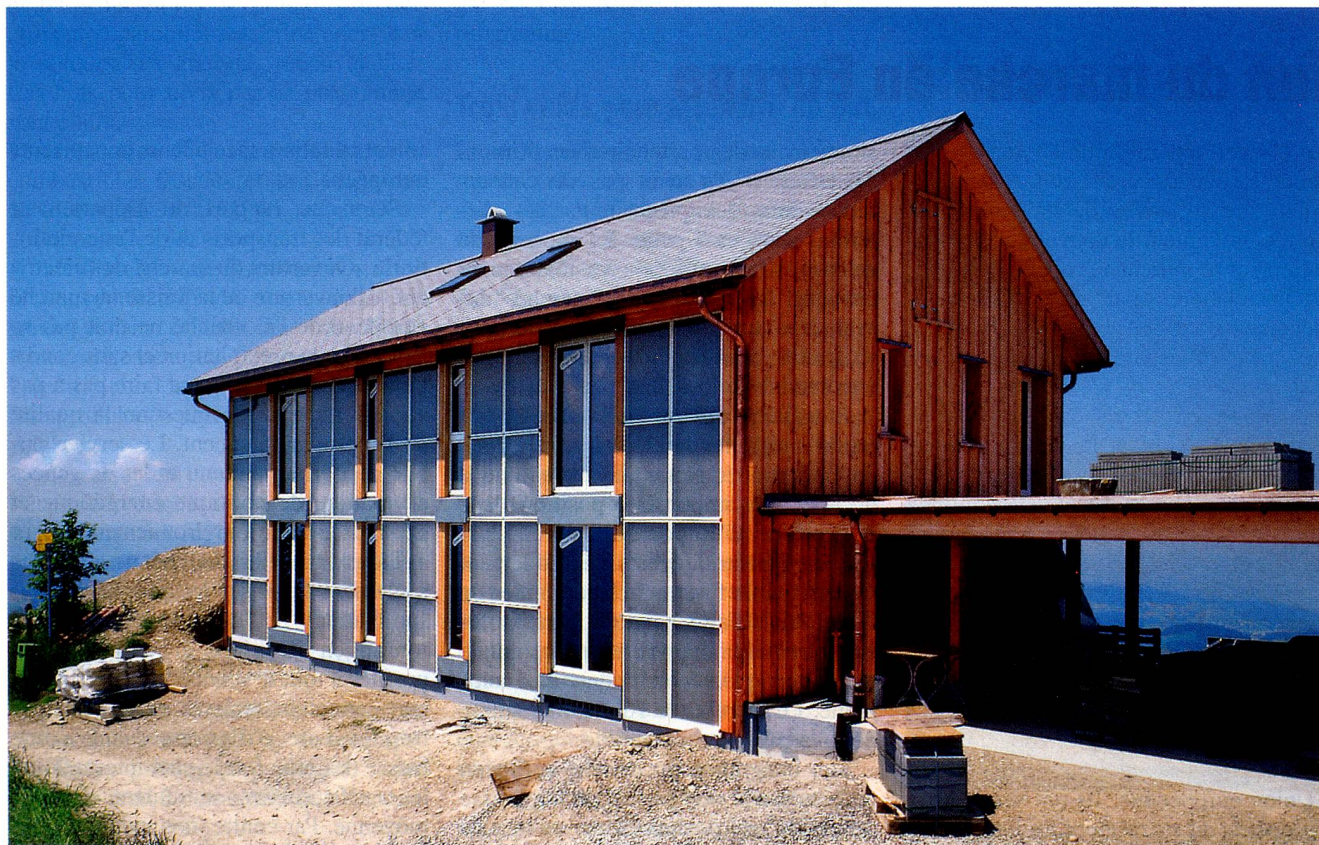
Projet-pilote dans le canton d'Appenzell: les murs de la maison sont construits selon la nouvelle technique d'isolation thermique avec emmagasinement de l'énergie solaire. (Photo: Oerlikon Journalisten)
