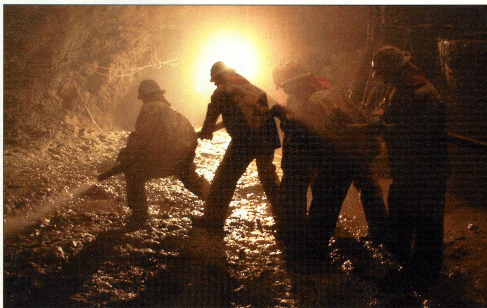
Le travail en équipe: clé de voûte d'un chantier souterrain.
