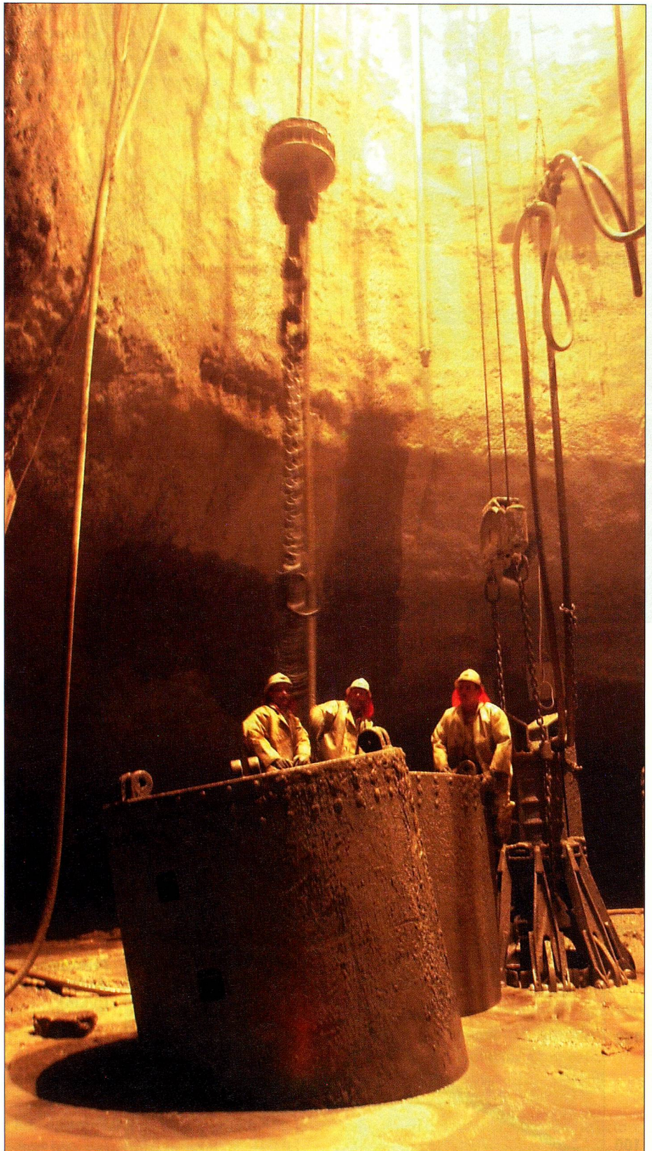
Le tunnel de base du St-Gothard est ce qui se fait de mieux: long de 57 kilomètres, il sera, à sa mise en service, le plus long tunnel ferroviaire jamais construit.
