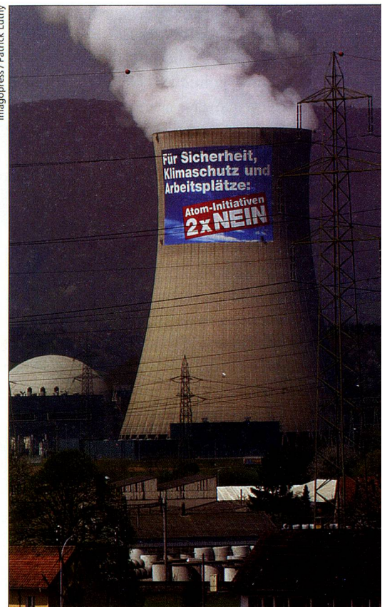
Mots d'ordre des votations sur la tour de refroidissement de la centrale nucléaire de Gösgen. L'affiche géante mesure 64 m de long sur 44 de haut.
