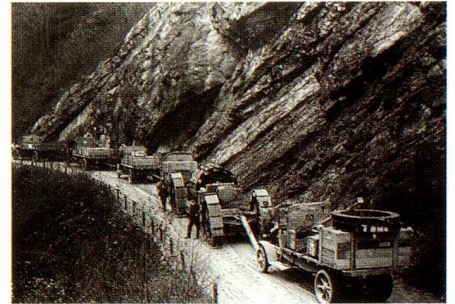
Histoire de l'industrie: Des camions de Brown Boveri transportant, en 1924, des pièces de générateur au «Wägitalersee».
