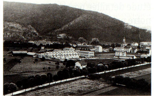
Les premières usines de BBC à Baden en 1892. À l'avant-plan, la route arborée assurant la liaison entre Bâle et Zurich.
