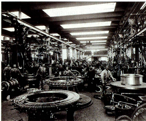
Vers 1910 dans la bobinerie. À droite, le façonnage d'une pièce de rotor.
