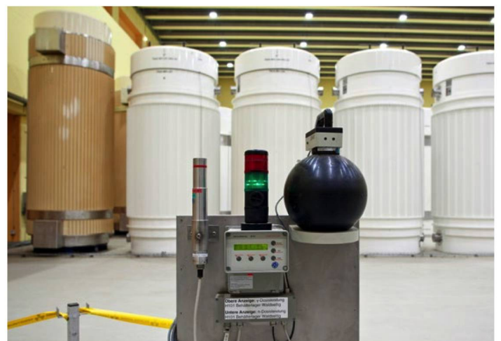
Conteneurs de déchets hautement radioactifs dans le dépôt intermédiaire de Würenlingen, avec appareils de mesure de surveillance au premier plan. Photo Keystone
