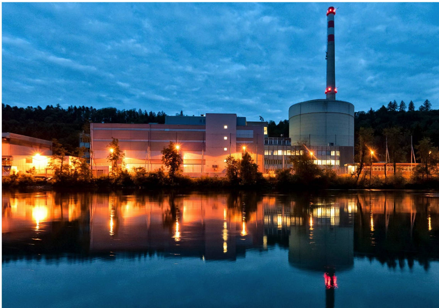
Bientôt, les lumières de la centrale nucléaire de Mühleberg s'éteindront. Photo Keystone
